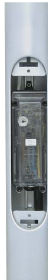
Złącze słupowe we wnęce słupa aluminiowego
